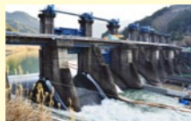
撤去が進む荒瀬ダム(熊本県八代市)
