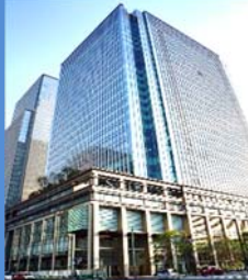
▲日本橋室町三井タワー
