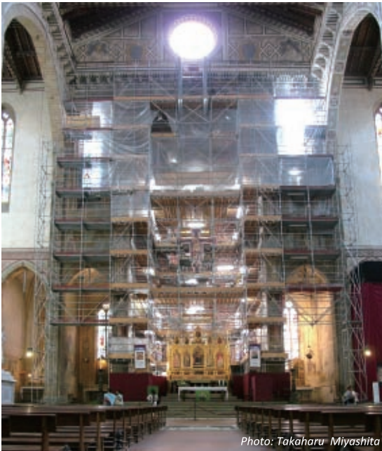
Photo: Takaharu Miyashita サンタ・クロチェ教会に建設された「開かれた足場」
