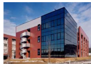
インキュベーション施設
