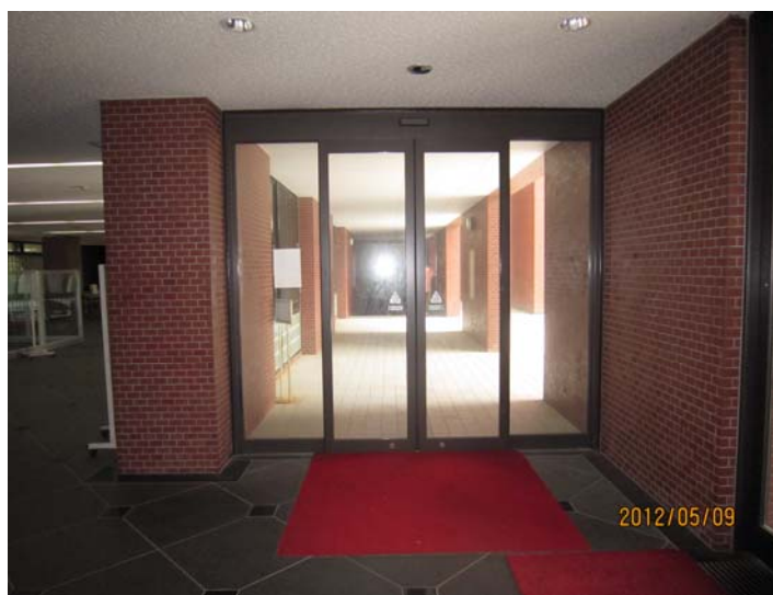
【データ7-4】人間社会第1講義棟自動ドア取設・スロープ取設
